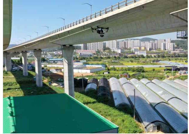
드론 활용 교량 점검
